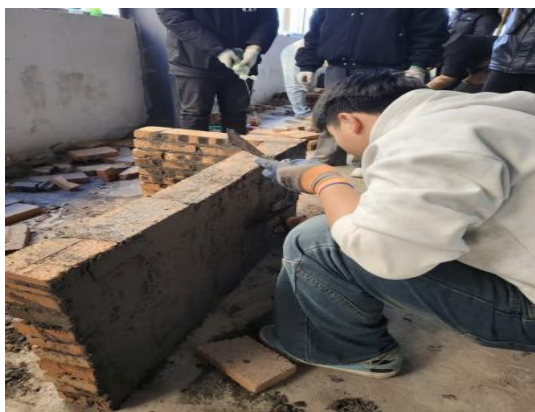
图 2-41 学生进行抹灰实操
